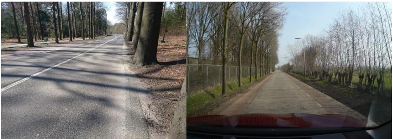
Figuur 10: vuile markering en versleten markering
