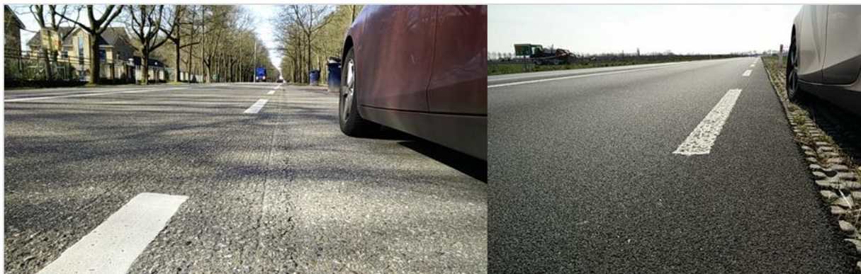
Figuur 5: onderzochte typen markering - links thermoplast, rechts spettermarkering/agglomeraat
