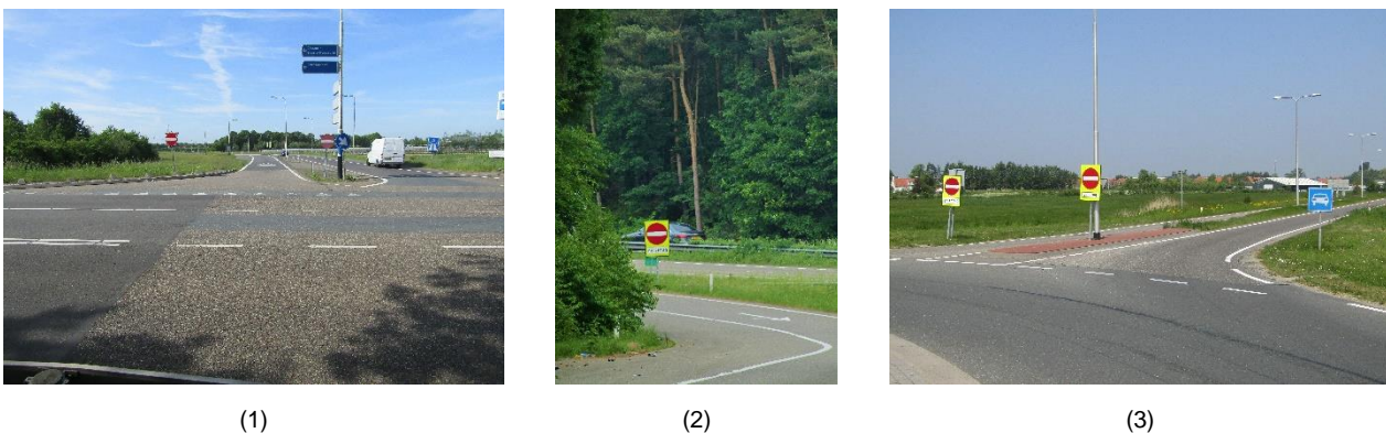
Figuur 4: Voorbeelden van mogelijk incorrect uitgevoerd wegontwerp. (1) De wegmarkering op de kruising kan verkeerd worden geïnterpreteerd en overschreden worden, waardoor men de afrit van de autosnelweg kan kiezen in plaats van de toerit. (2) Het bord C2 met onderbord "ga terug" is geplaatst dichtbij het divergentiepunt op de autosnelweg. Op dit punt kan de potentiële spookrijder niet meer open staan zijn voor dit gebod en/of het gebod negeren. (3) Hier staan de borden C2 met onderbord "ga terug" dichtbij de kruising waar ze duidelijk zichtbaar zijn voor verkeer in de correcte rijrichting. Bovendien dienen deze borden als een herinnering gebruikt te worden, hetgeen impliceert dat de borden in de verkeerde context gebruikt worden.
